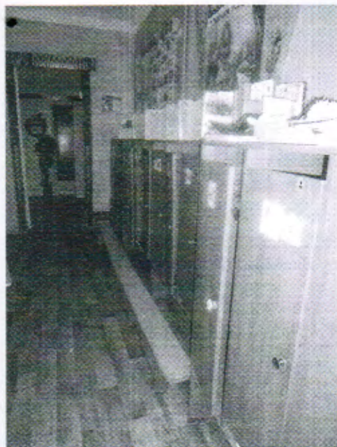
Фото № 22. Коридор здание № 2
