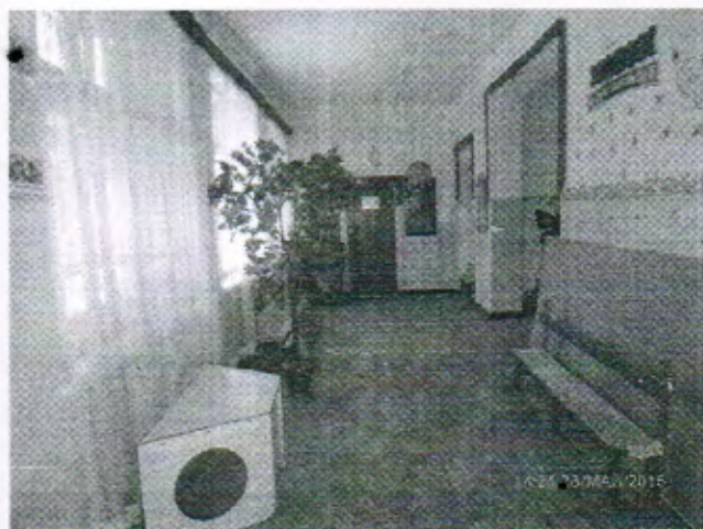
Фото № 11 Коридор -здание № 1 (1 Этаж)
