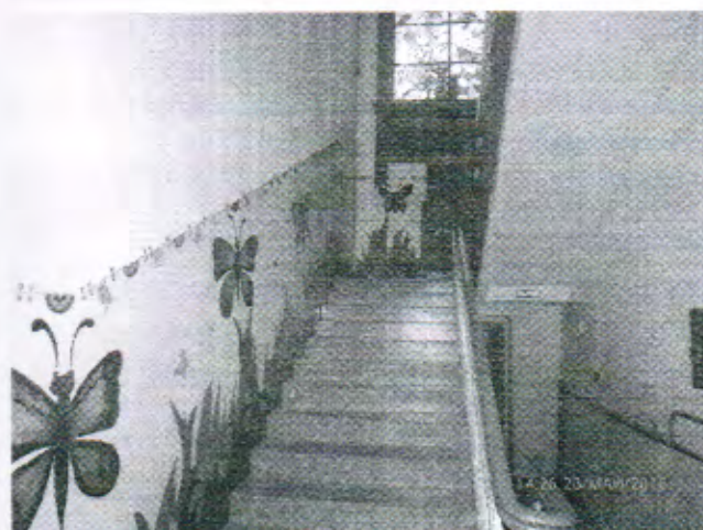
Фото № 7. Лестница на 2 этаж – здание № 1
