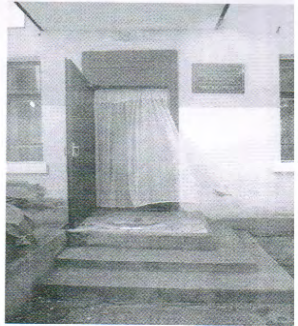
Фото № 3. Лестница - здание № 1.
