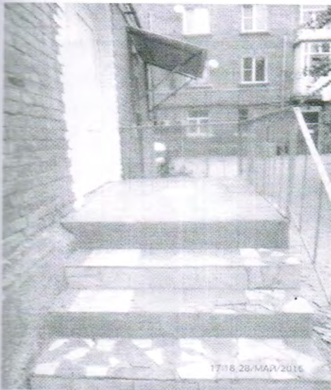
Фото № 22. Лестница - здание № 2
