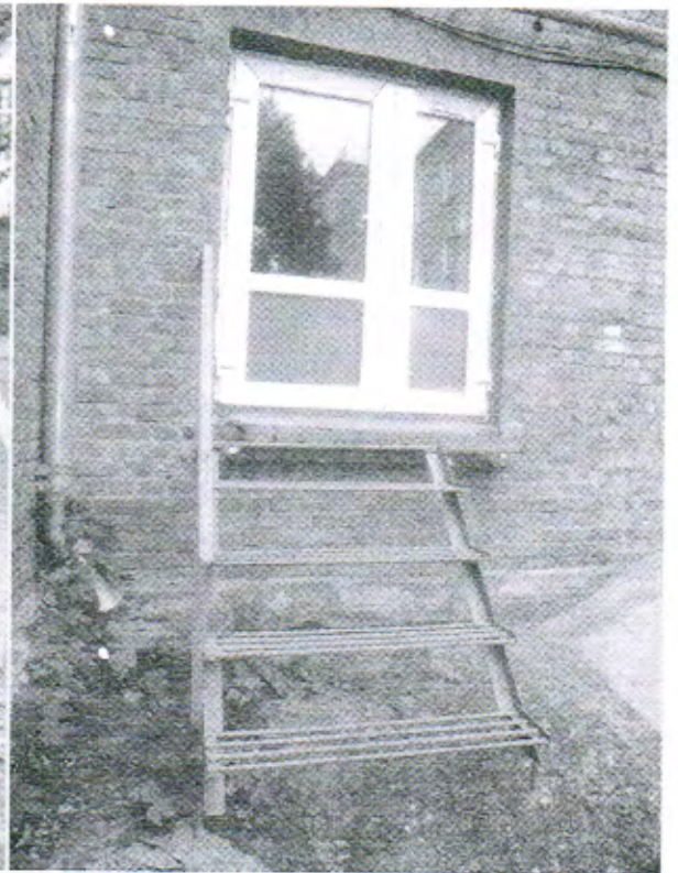
фото № 38. Эвакуационный выход Здание № 2
