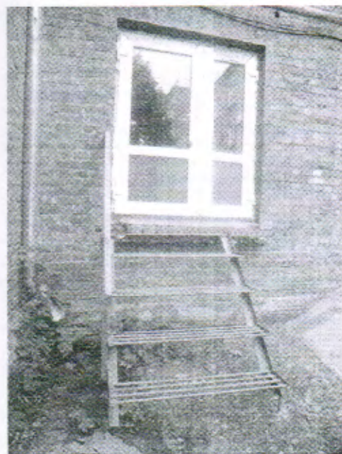
Фото № 38. Эвакуационный выход – здание № 2
