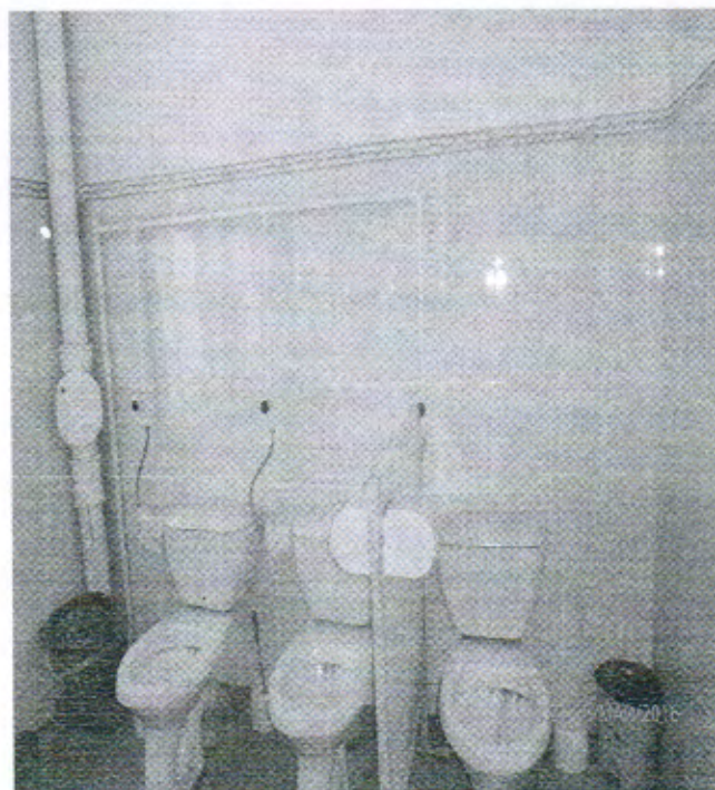
фото № 9. Туалетная комната здание № 1
