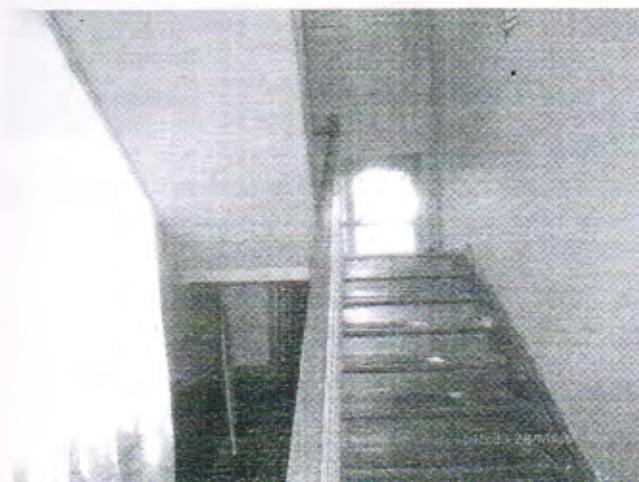
Фото № 13. Эвакуационный выход – здание № 1
