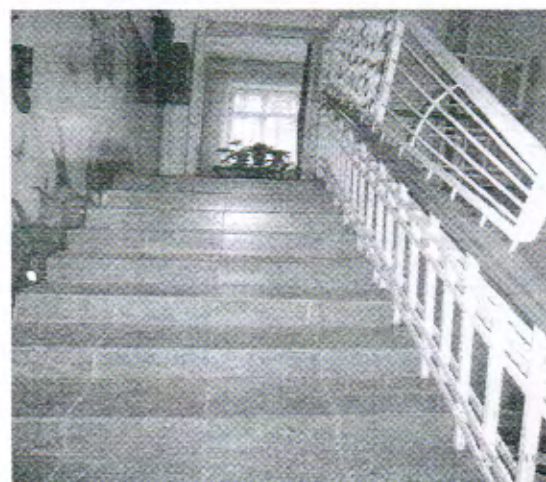
фото № 6 лестница на 2 этаж –здание №
